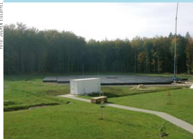
Den nyinstallerade LOFAR-stationen i tyska Tautenburg är identisk med den som kommer att installeras vid Onsala våren 2010.
