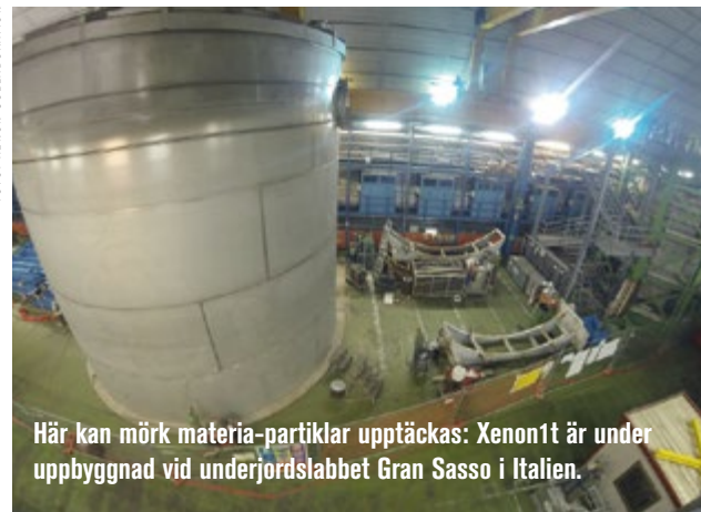
Inuti Xenon1t:s stora vattentank. I mitten av den ska en mindre tank hänga, fylld med ett ton flytande xenon.
